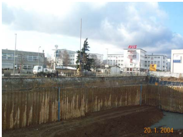
Baugrubenaushub und Spundwände
