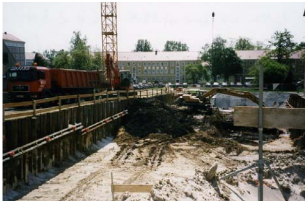
Tiefbauarbeiten im 2. Bauabschnitt
