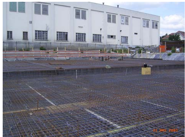
Bewehrung der Bodenplatte
