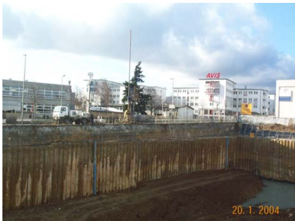
Baugrubenaushub und Spundwände
