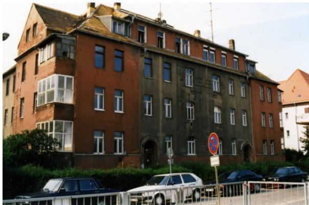
Ansicht vor der Sanierung und
