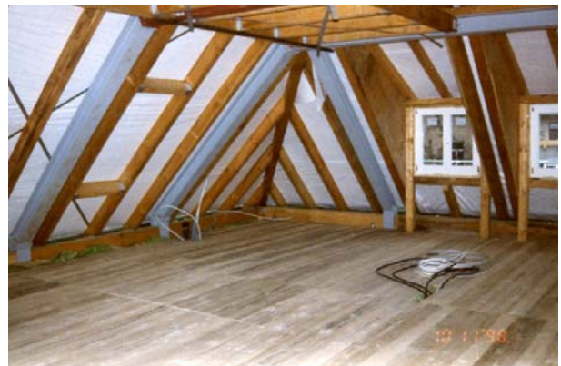
Ausbau Dachgeschoss für 3 neue Wohnungen
