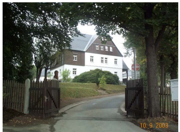
Ansicht nach der Sanierung
