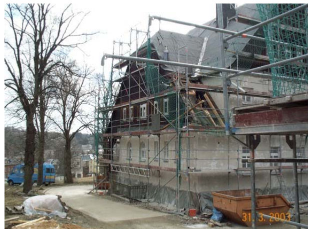
während der Sanierungsarbeiten
