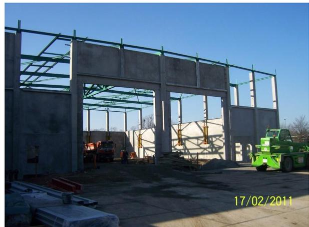
Rohbau der Halle mit Stahlbetonfertigteilen
