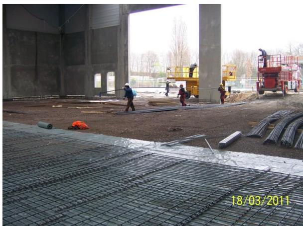
Herstellung Bodenplatte unter „geschlossenem Dach“
