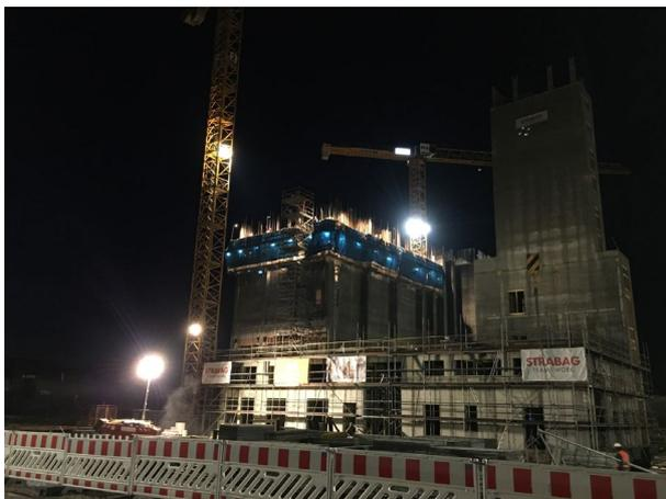
Nächtliche Gleitbauarbeiten am Mischbunker
