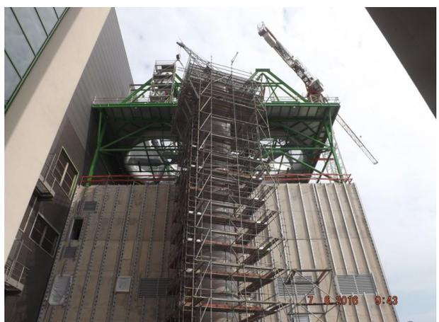
**Montage Stahlkonstruktion einschl. LuKo auf dem Dach**
